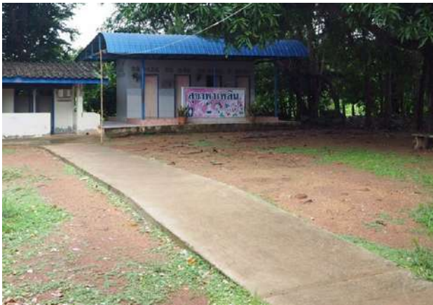
ก่อนทำหลังคาทางเดินเข้าห้องน้ำ
