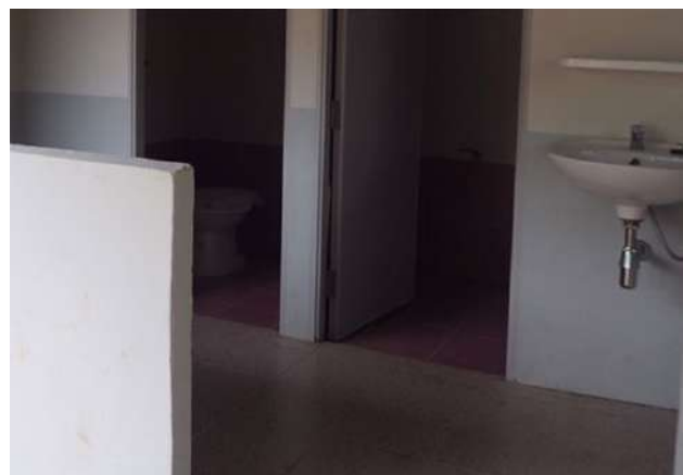
หลังจากปรับปรุงห้องน้ำ
