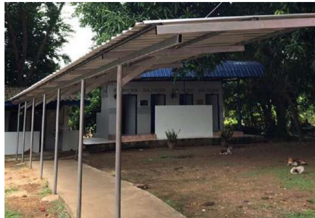
หลังจากทำหลังคาทางเดินเข้าห้องน้ำ
